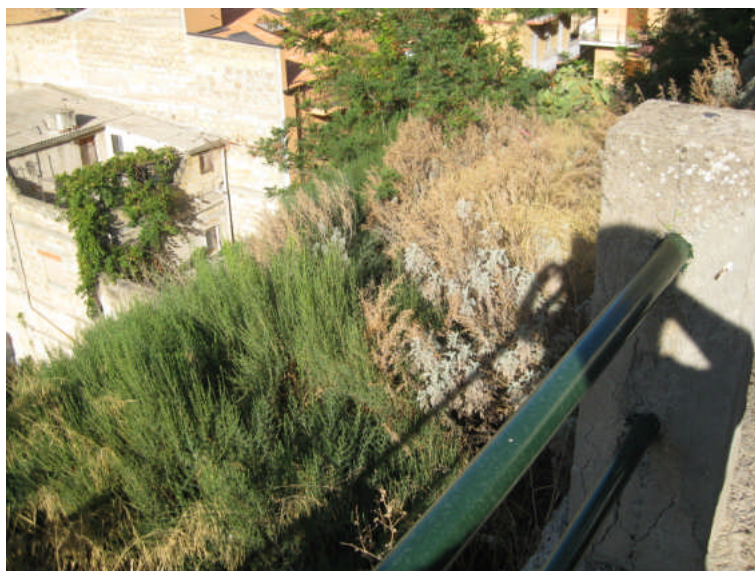
Foto n. 2 – Costone roccioso compreso tra la via SS. Crocifisso e la via Chiamonte
