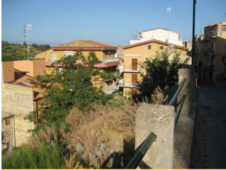
Foto n. 8 – Particolare del costone tubaceo e della porzione di sede stradale di monte
