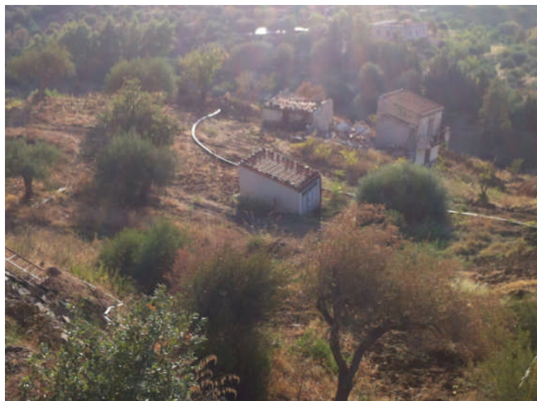
Foto n. 10 – Particolare della frana che ha coinvolto case sparse e un tratto di acquedotto
