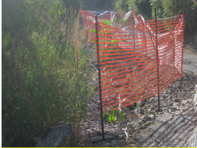
Foto n. 3 – Particolare della strada - via Landro - interessata dal dissesto complesso
